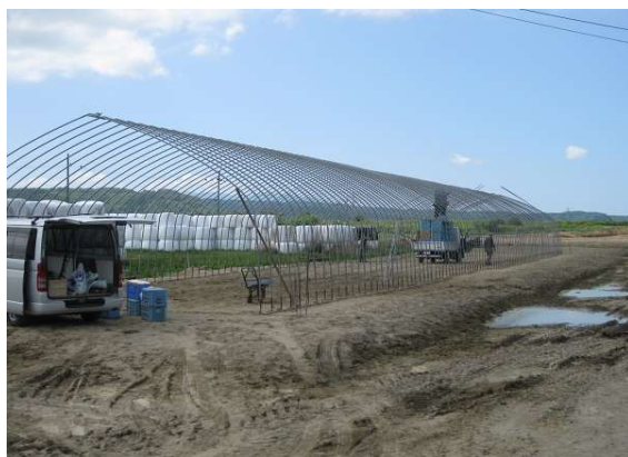
C農場 ハウス牛舎建設中
