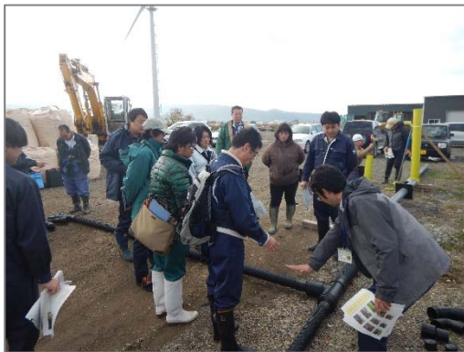
施工業者さんのご厚意で暗渠をモデル的に配置していただきました。
