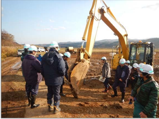
掘削バケットについて説明
