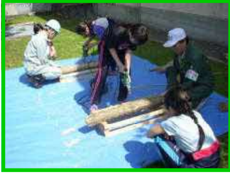
穴あけ作業の様子
