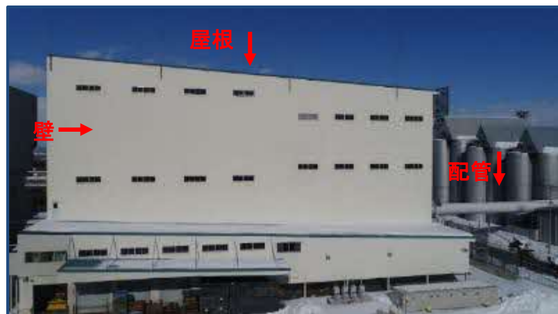
小麦の乾燥施設、倉庫、事務所などの点検 ※JAめむろ様
