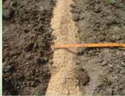
補助暗渠の施工断面図
