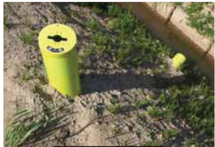
水位調整型水閘
