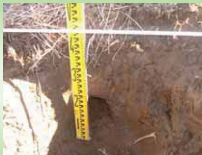
補助暗渠の施工断面図
