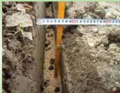
補助暗渠の施工断面図
