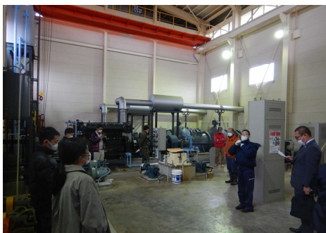
2日目 西兜野排水機場
